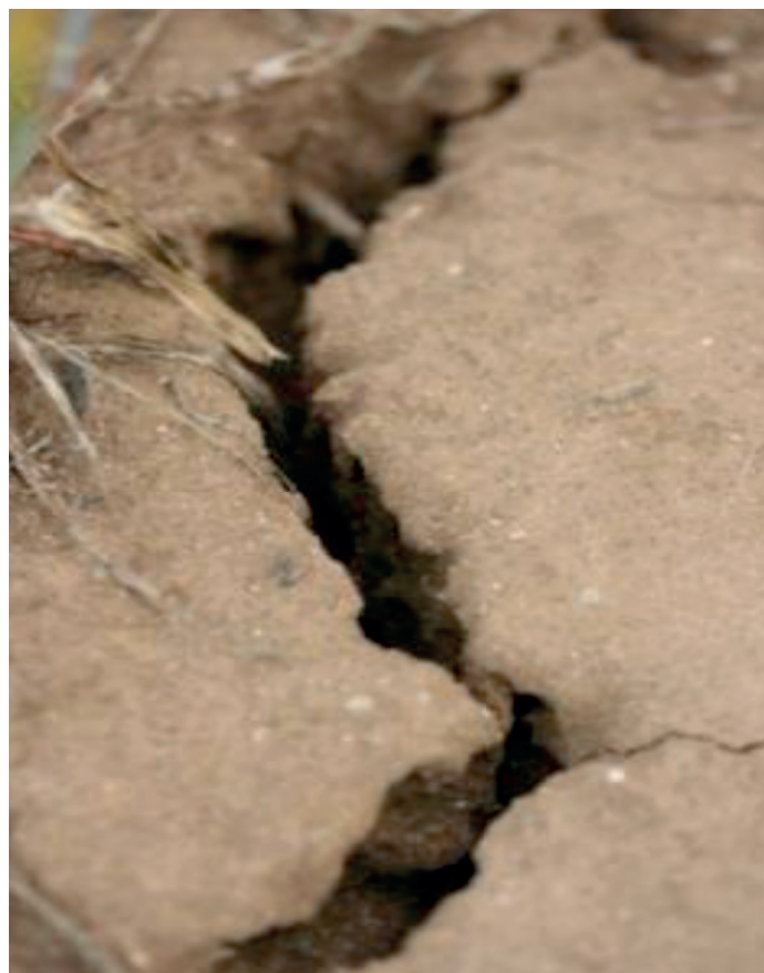
Grietas en un suelo arcilloso
